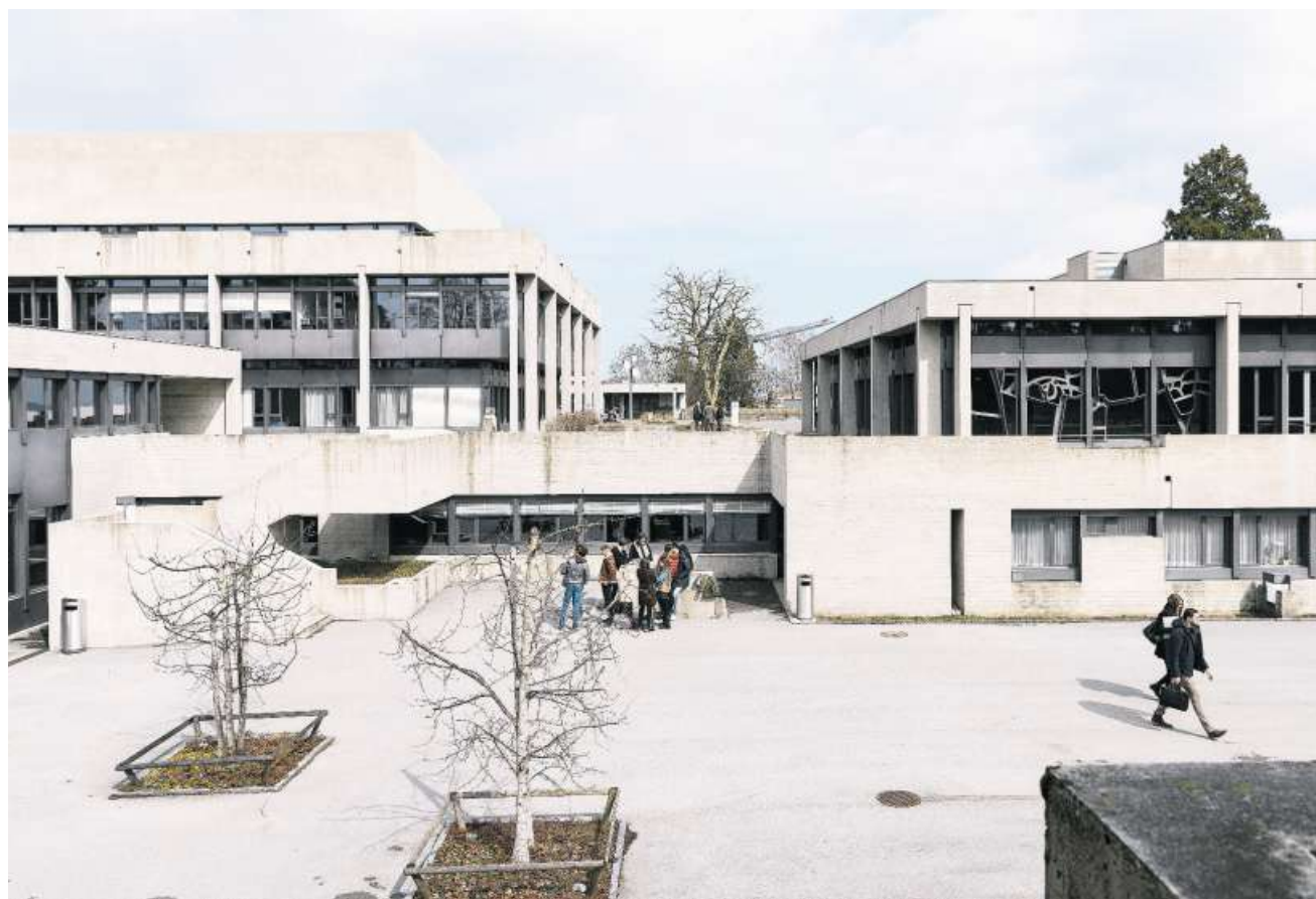
Die Gebäude der HSG sind für 5000 Studierende konzipiert, zurzeit studieren hier 8700 Personen.
