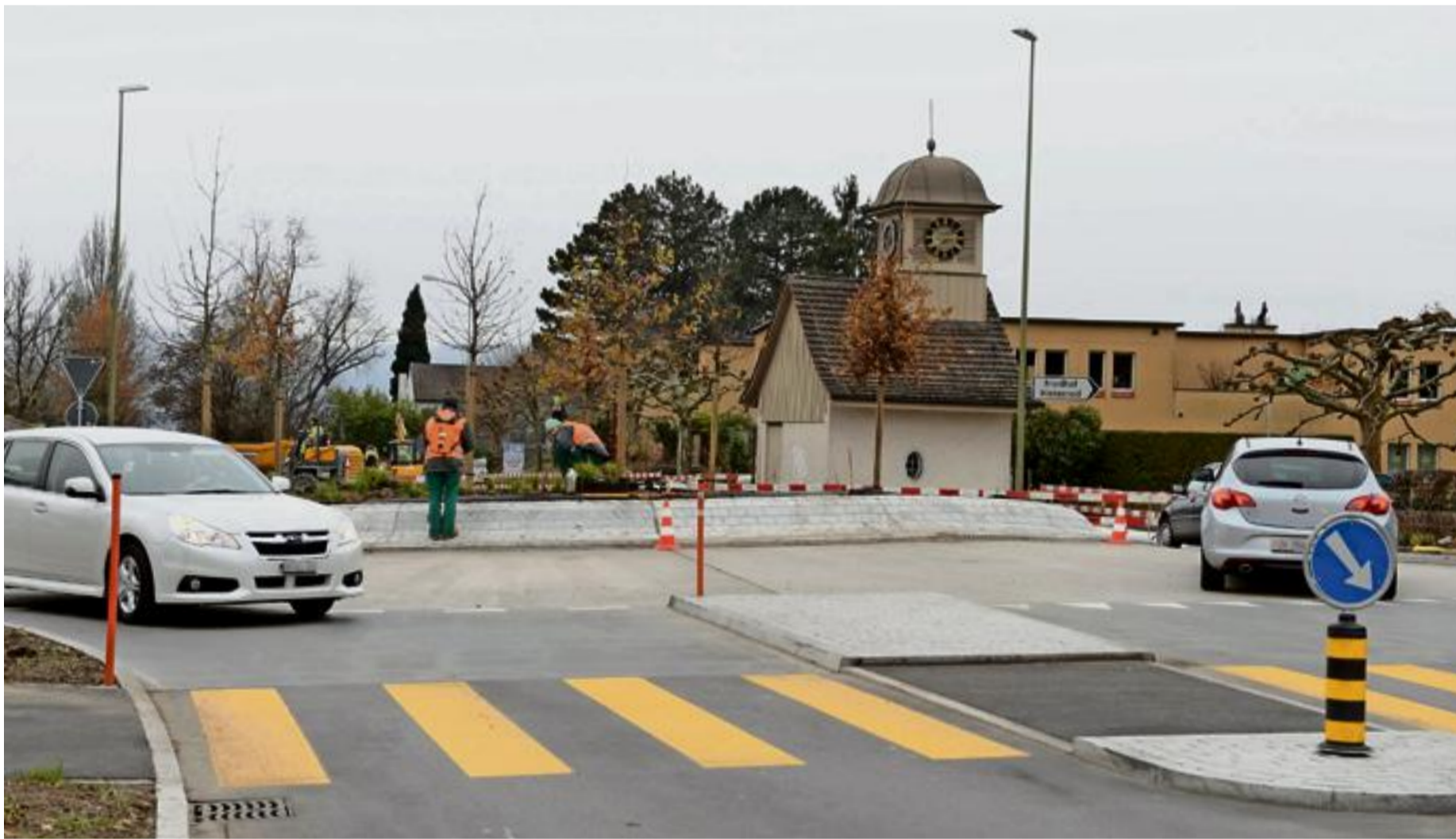
Im Innern des Kreisels in Itschnach sind die Bauarbeiten noch im Gang. Der Verkehr rollt aber bereits um den Kreisel herum – sofern die Autofahrer ihn nicht übersehen. Reto Schneider
